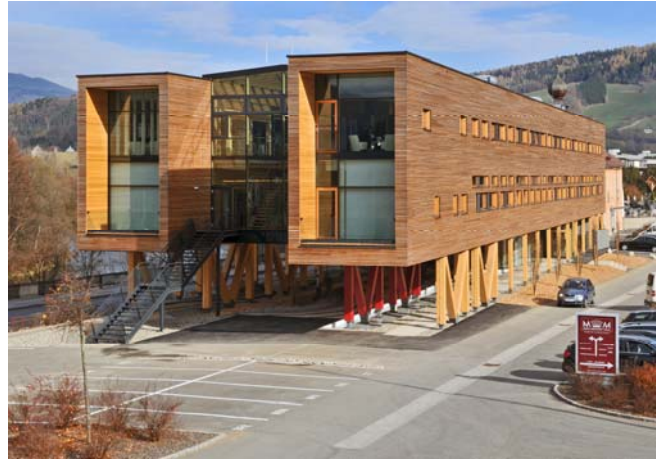
Frontansicht des neuen Gebäudes, © Alexander Koller 2008
